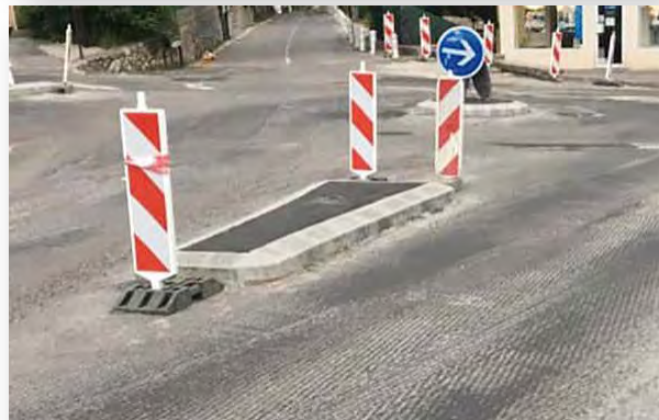
Fig. 4 Exemple d'une infrastructure ralentisseur
