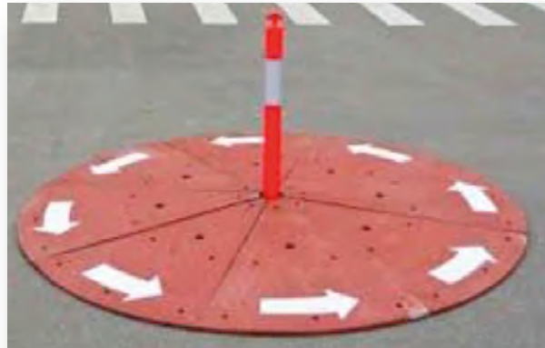
Fig. 3 Exemple de mini giratoire franchissable
