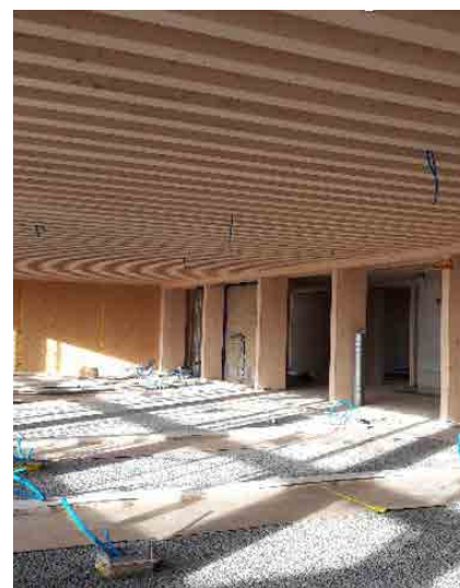
Ecole de Marly en construction avec du bois local
