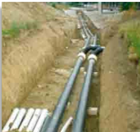
Fig 2 exemple de tubes posés dans le sol (source groupe e)
