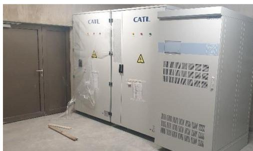
Figure 3 Batteries posées dans le local " Batteries"
