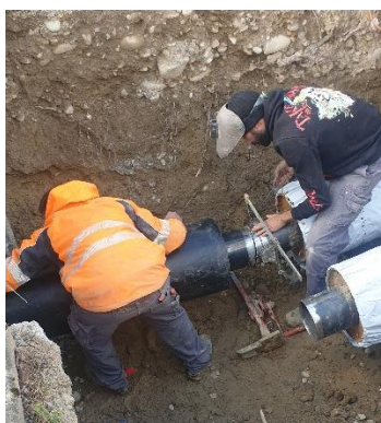
Figure 1 Extension du réseau CAD vers la nouvelle chaufferie. Soudeurs en action
