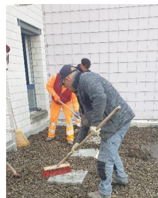
Figure 3 Préparation pour la pose de l'aéro-échangeur
