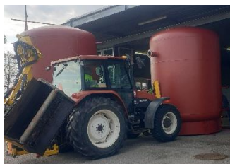
Figure 1 Mise en place des accumulateurs
